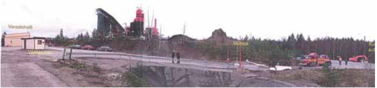
Kuva 3. TOT 20/08 raportin kuva, josta kaltevuus varastohallin kohdalla ilmenee. Kuvan keskikohdalla tiessä on kaarre, jossa kuorma-auton peruutussuuntainen reitti ohjautui ajoradan kallistuksen ja ohjaavien renkaiden myötävaikutuksella, eikä kuorma-auto ohjautunut ulko-kaarteeseen kaiteeseen.
