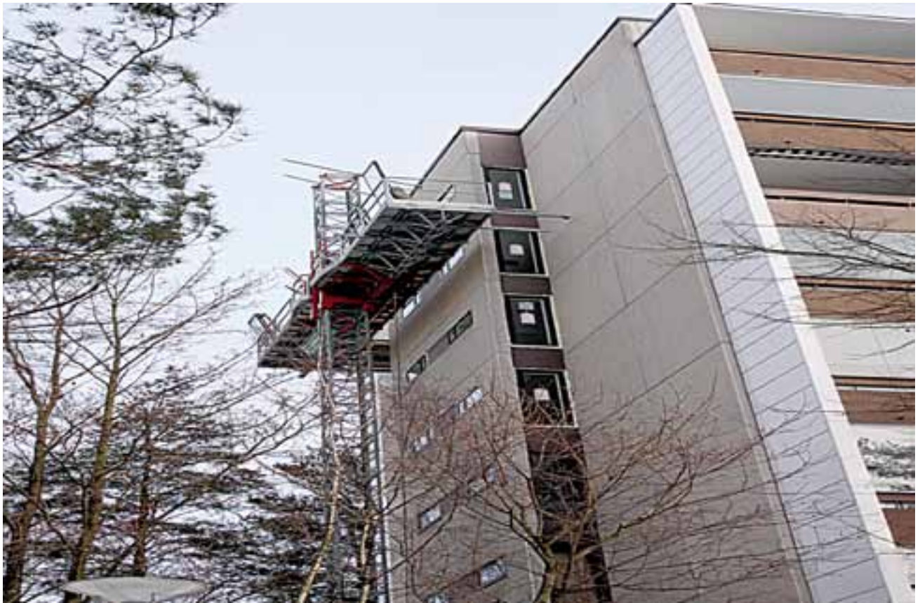
Kuva 2. Mastolavan varsinaista työtasoa kasvatettiin konsolilevennyksellä käyttäen kolmea teleskooppista levityspotkea.
