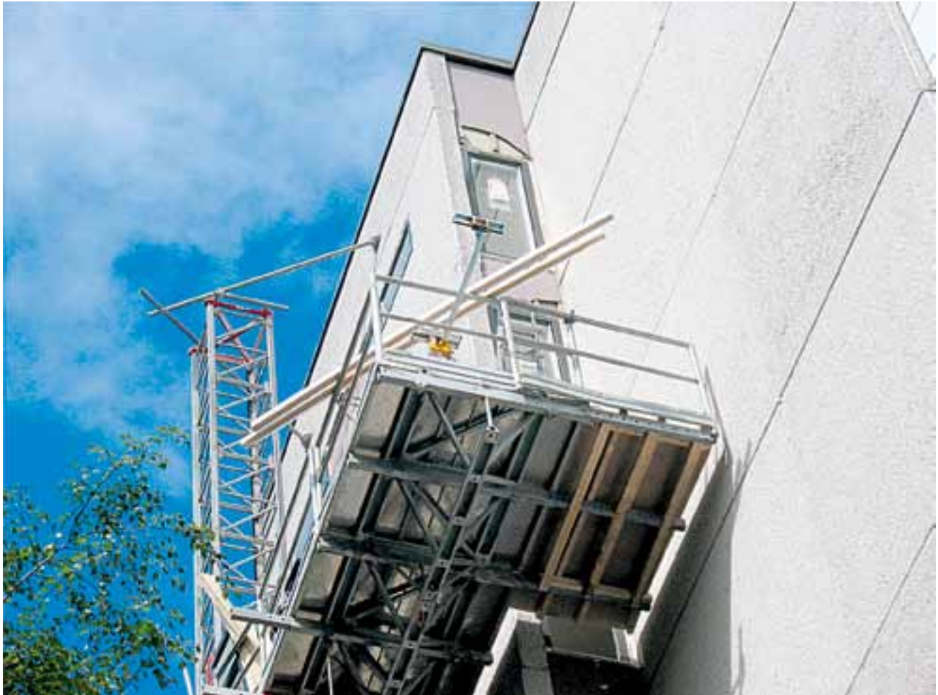
Kuva 11. Maston ankkurointi seinärakenteisiin ja käyttötarkoitukseen soveltuva työtaso levikkeineen.
