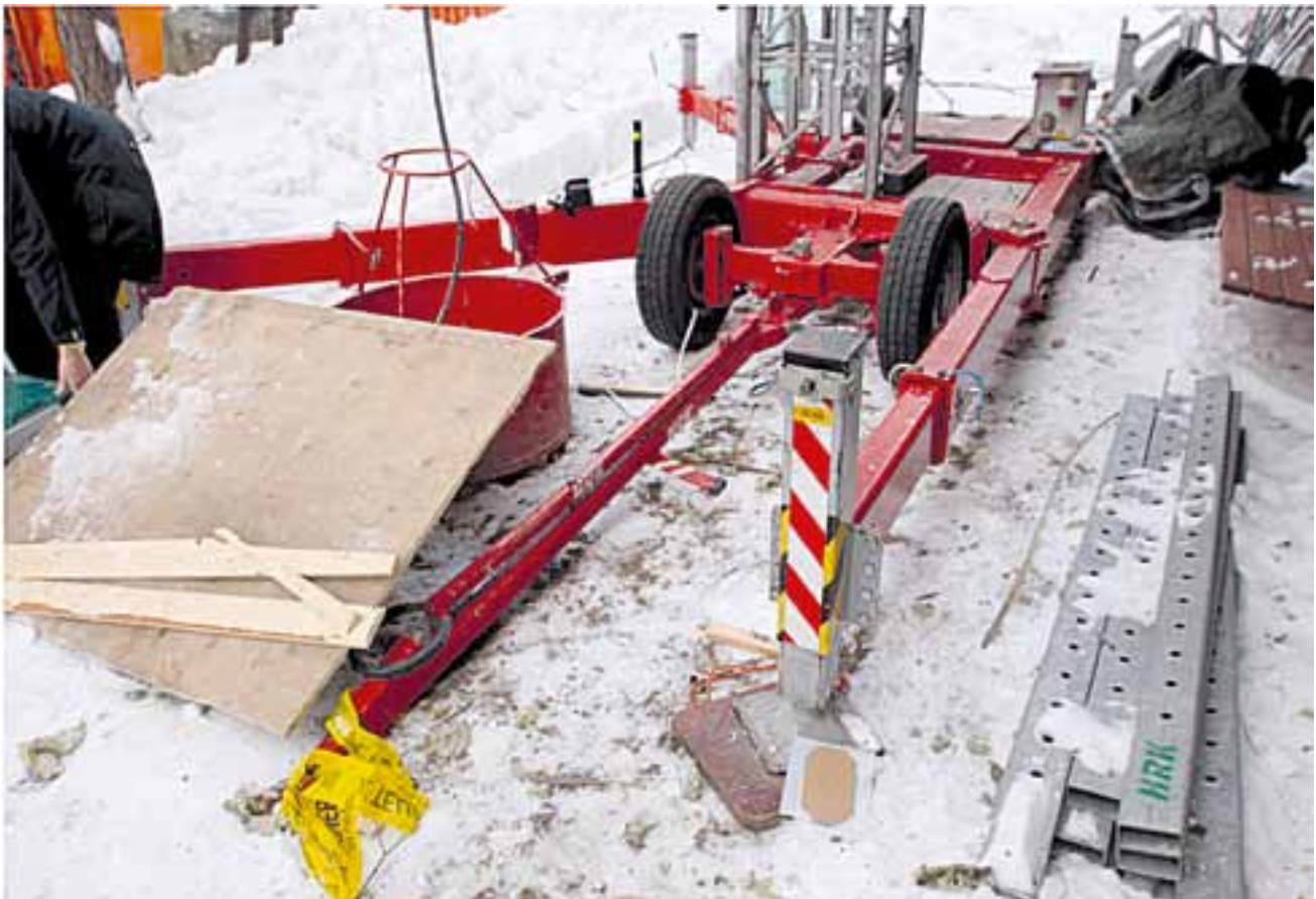
Kuva 3. Mastolava oli perustettu lumiselle maapohjalle tukijalkojen varaan.
