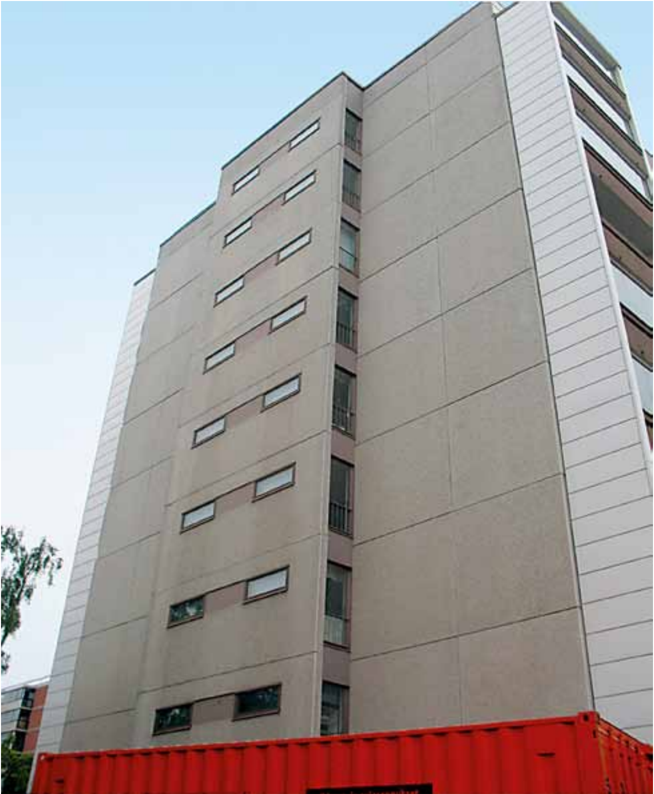
Kuva 1. Erkkerityyppisessä päädyssä oli uloke, jonka kummallakin sivulla oli ns. ranskalaiset parvekkeet.
