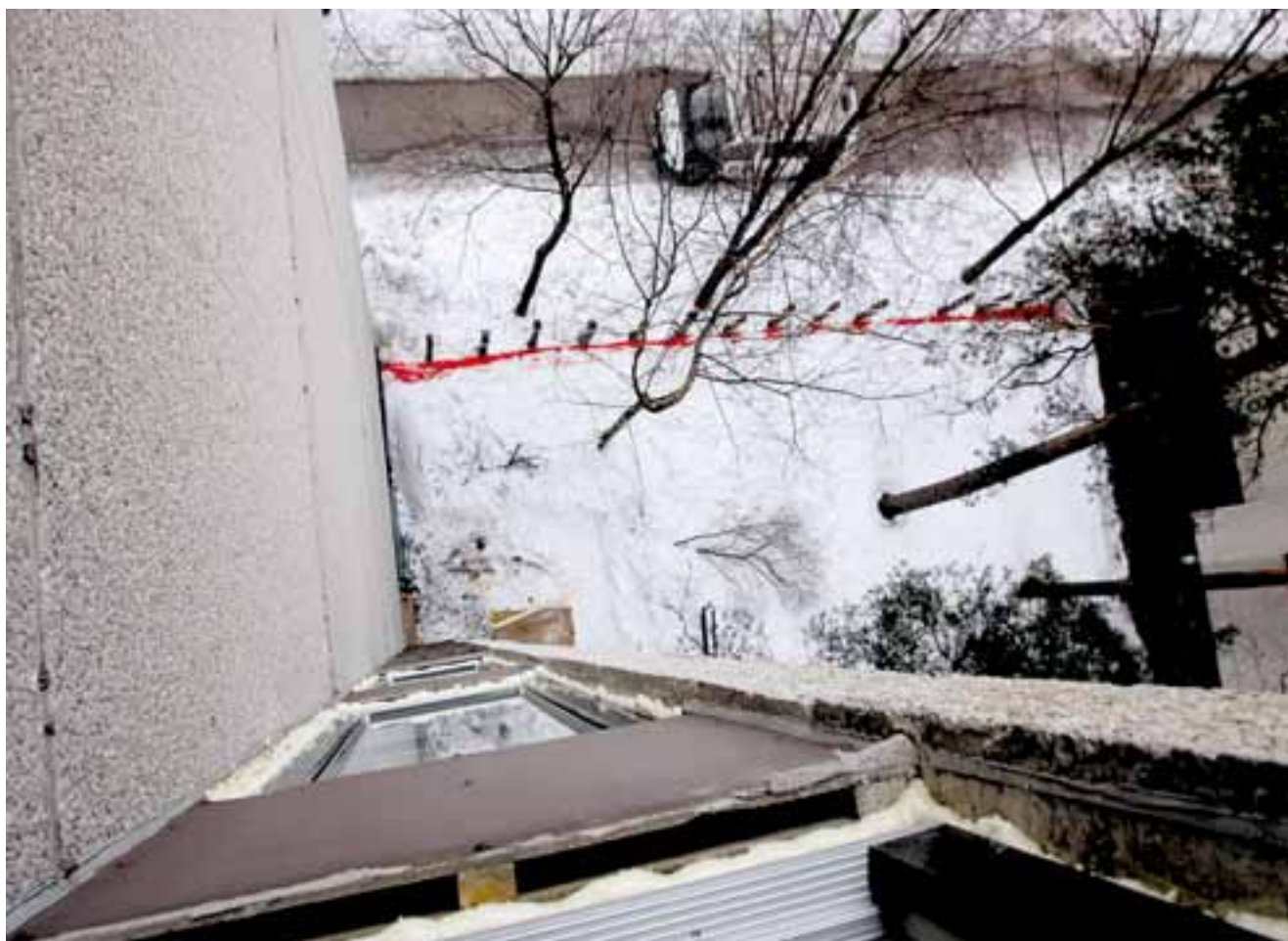
Kuva 5. NN putosi seitsemännen kerroksen kohdalla olevan mastolavan levikkeen ulokkeena olevalta työtasolta.
