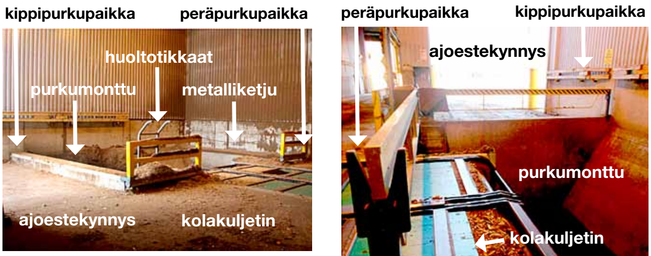
Kuvasarja 4. Ensimmäisessä kuvassa monttu purkupisteineen ennen ja toisessa jälkeen tapaturman ja torjuntatoimenpiteiden.
