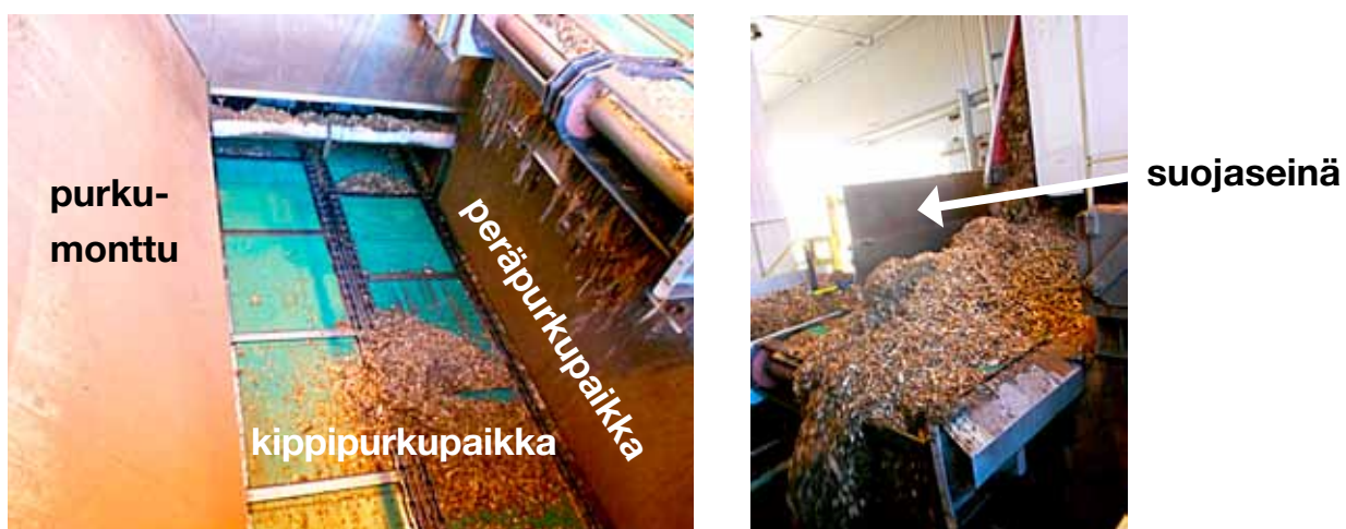
Kuvasarja 5. Ensimmäisessä kuvassa purkumonttu kippipurkupaikalta katsottuna ja toisessa hakekuorman purkua peräpurkupaikalla (kuvat otettu tapaturman jälkeen tehtyjen torjuntatoimenpiteiden valmistuttua, mm. kuvassa näkyvä suojaseinä).
