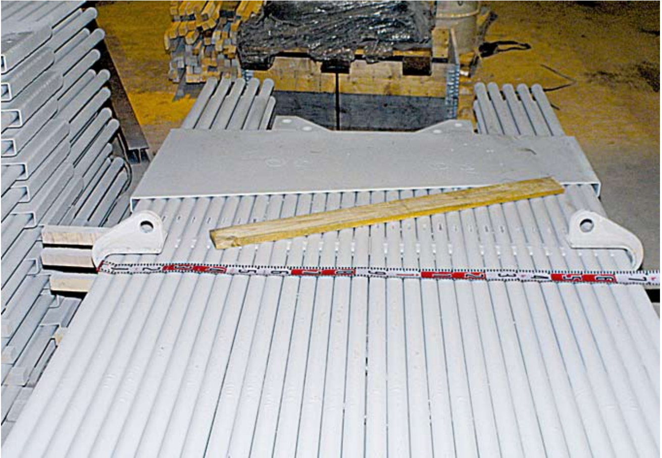
Kuva 1. Elementin avoimesta päästä sitä nostettiin tätä tarkoitusta varten tehtyjen nostoapuvälineiden, ns. nostolapikkaiden ja niihin kiinnitettyjen yksihaaraisten kettinkiraksien avulla.
