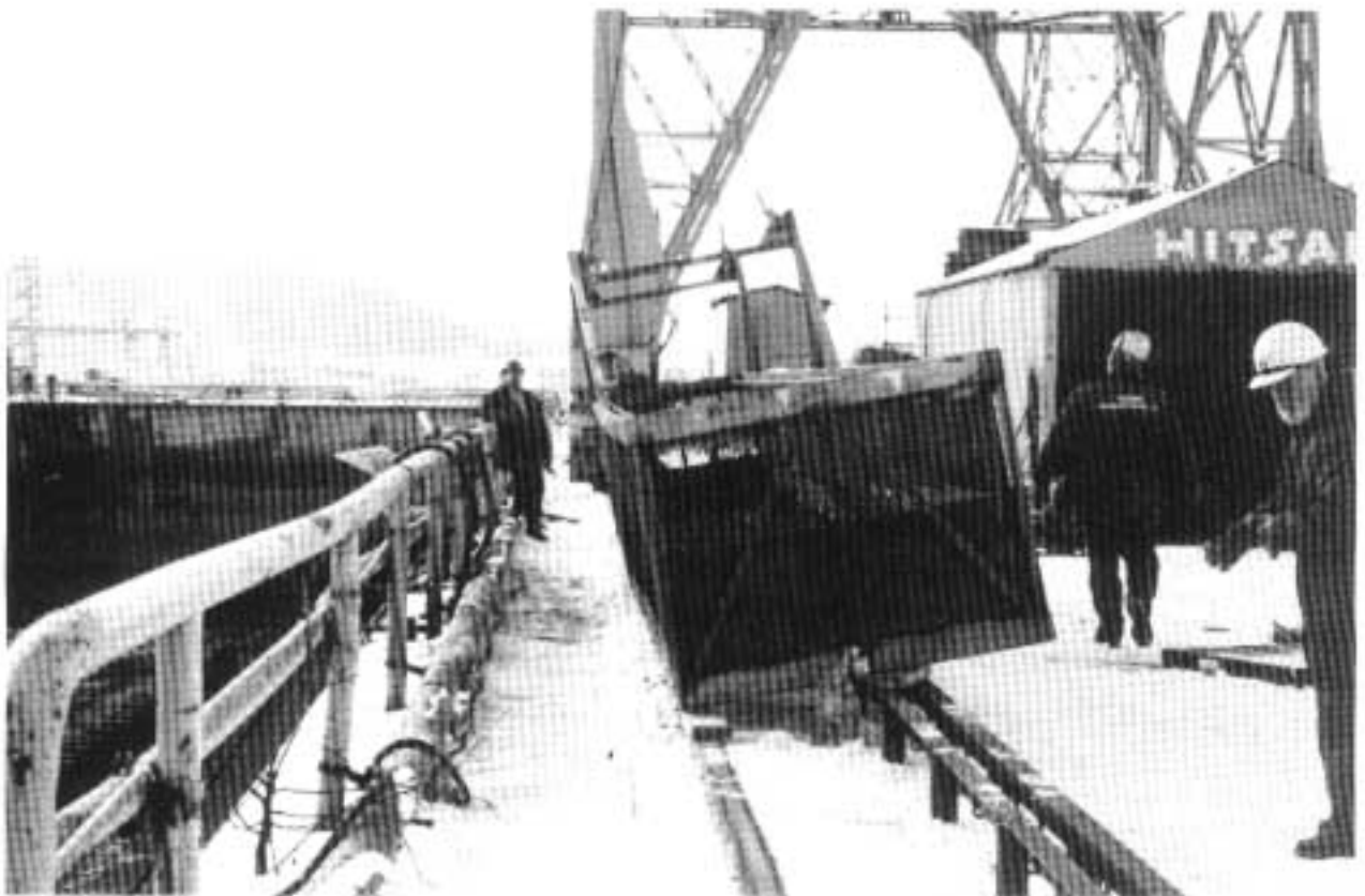
Kuva 2. Nostokori kiskoilla (kuvattu myöhemmin).
