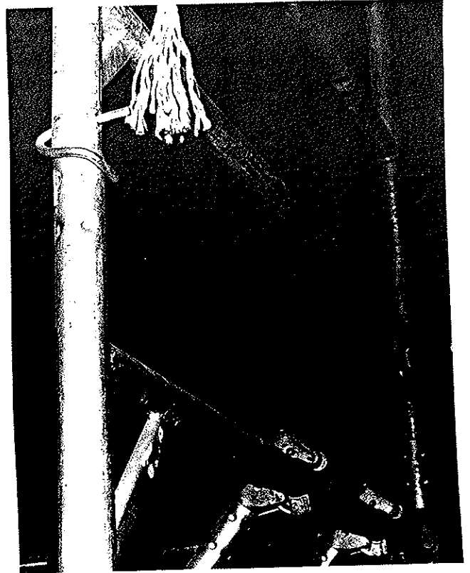
Kuvat 1 ja 2. Kuvassa 1 puuttuu liitoksen sokka. Kuvassa 2 sokka paikallaan.
