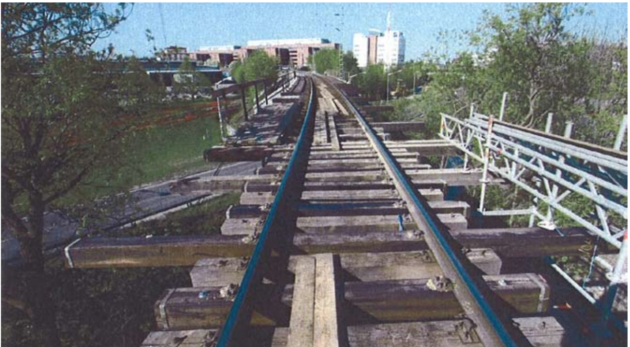
Kuva 2. Kuva sillalta. (taampana raiteen vasemmalla puolella kuvassa näkyy siirrettävä puinen apulava.) Kulkua ja työskentelyä varten ratapölkkyjen päälle oli asetettu lankkuja vierekkäin. Lankut oli siirretty sivuun hiekkapuhallettavasta kohdasta.
