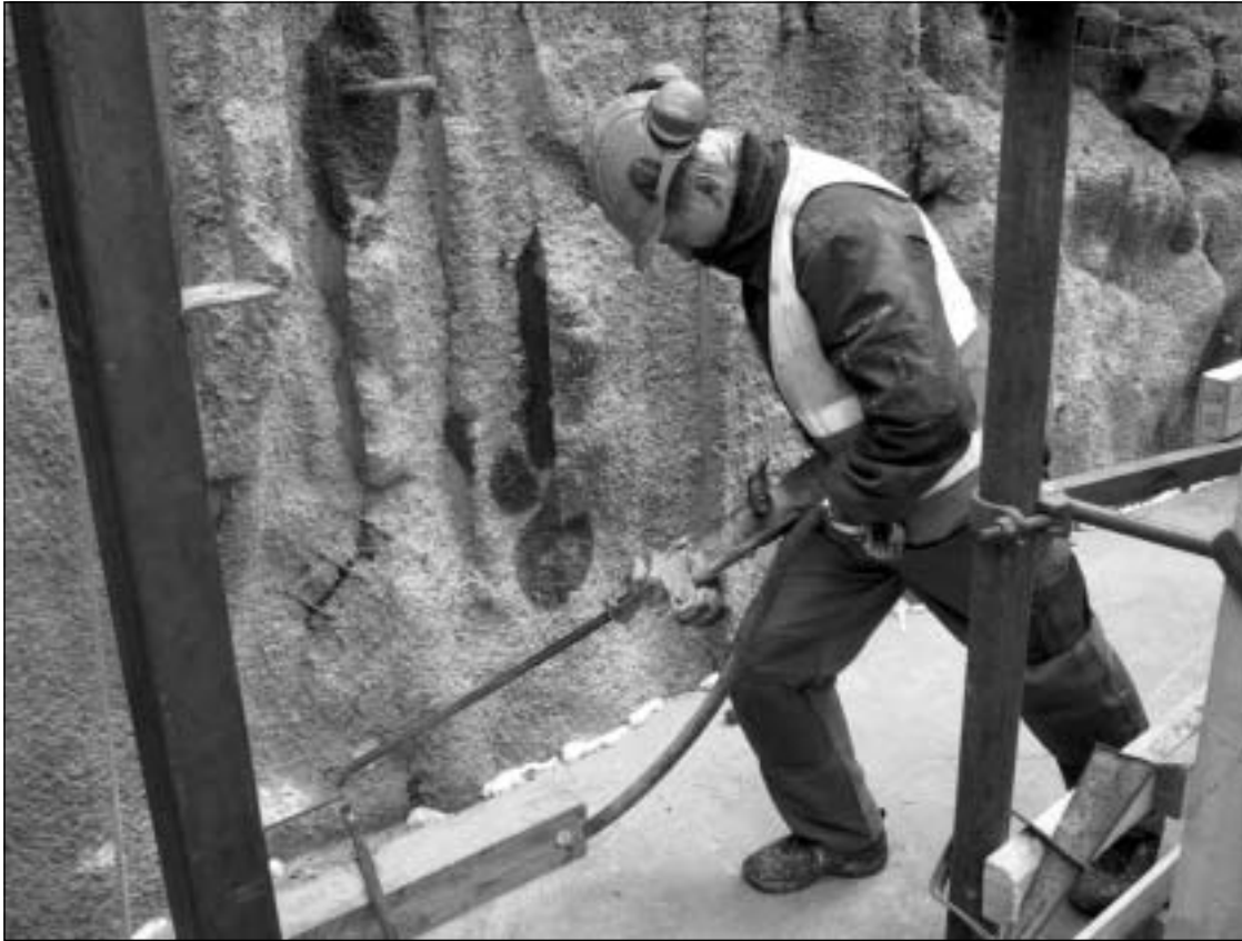
Kuva 3. Reiän poraus polvisyöttökoneella.
