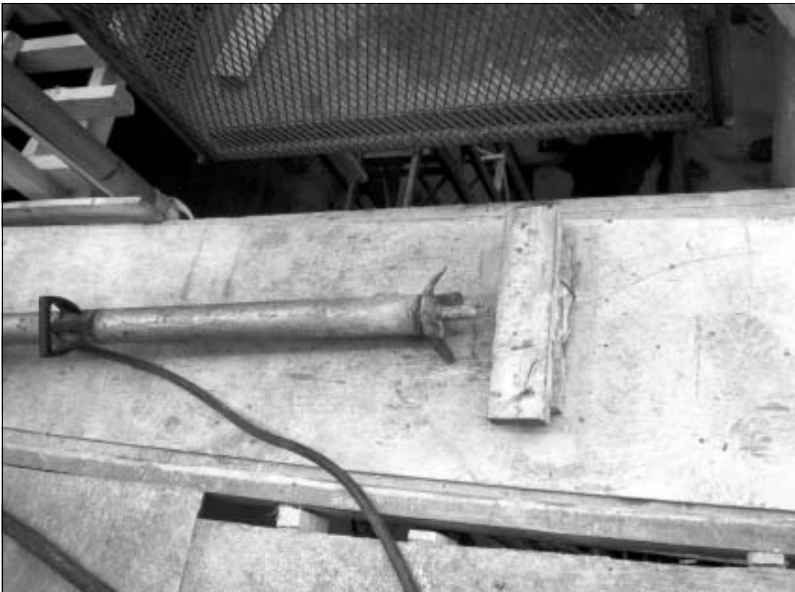
Kuva 2. NN nautasi kaksi lankkua poikittain kiinni kulkutason pintana olevaan vanerilevyyn polvisyöttökoneen jalan tueksi.
