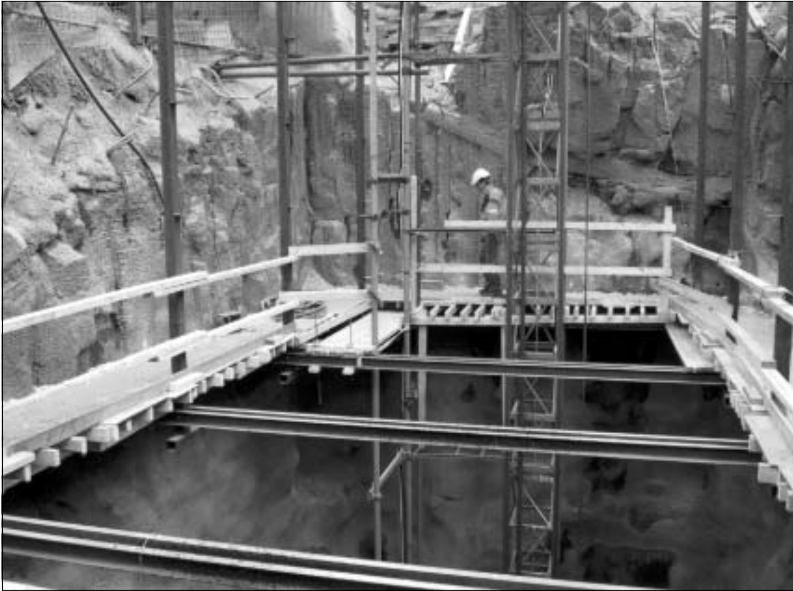
Kuva 1. Yleiskuva tapahtumapaikalta työmaahissin puoleisesta päädyistä.
