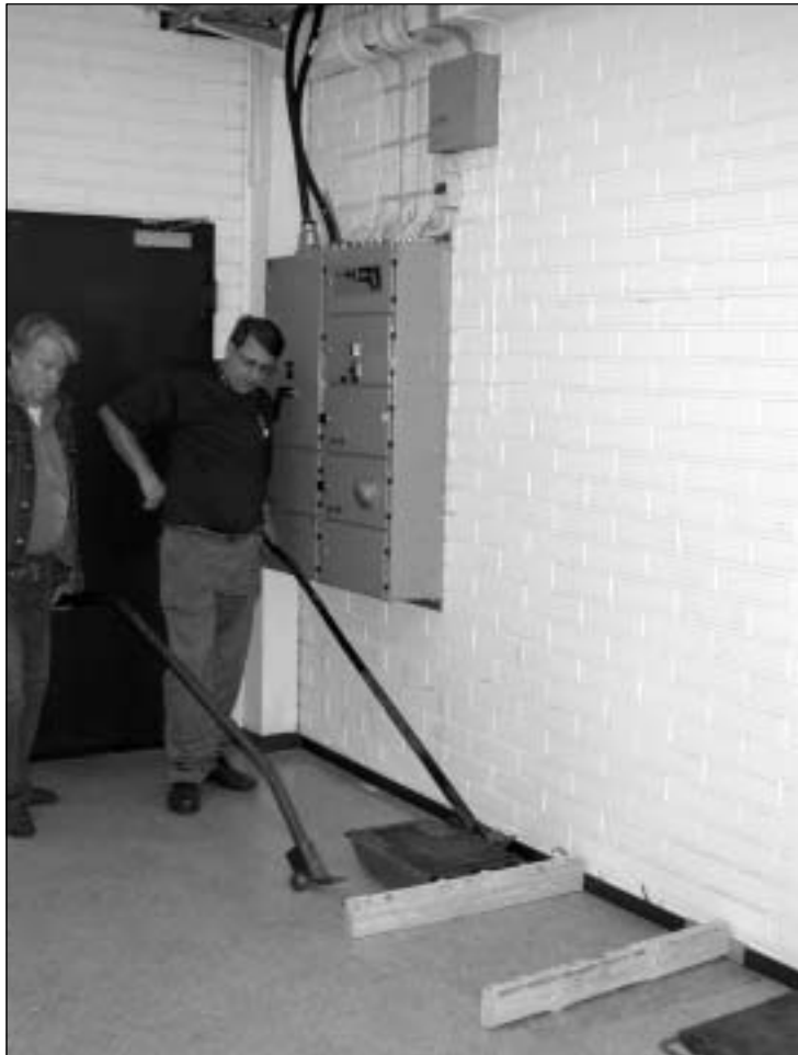
Kuva 2. Lavastettu tilanne siitä, miten kassakaappi kammettiin soirojen ja alustojen päälle.
