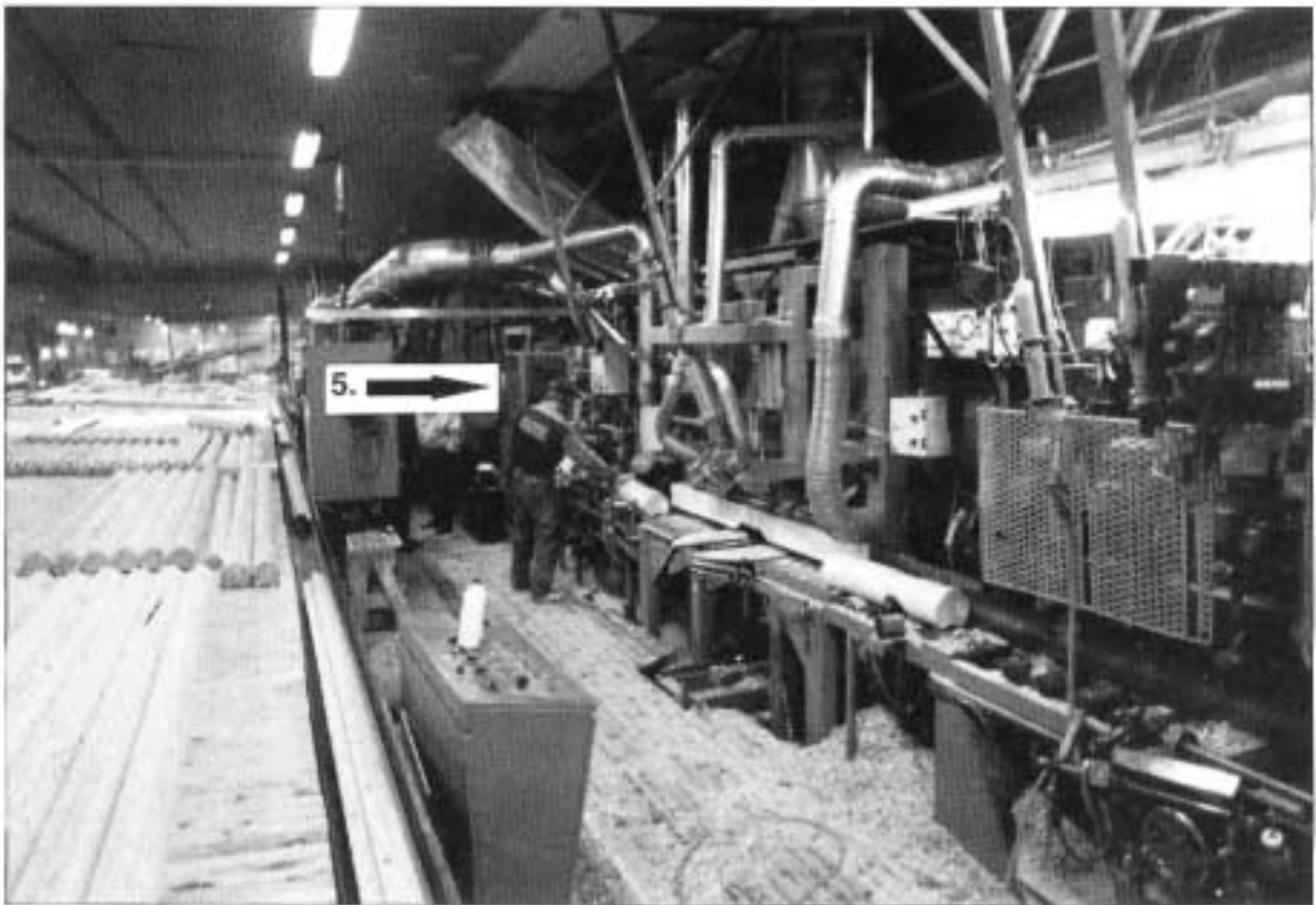
Kuva 6: Yleisnäkymä linjasta. Pielityöstökone (kohta 5).
