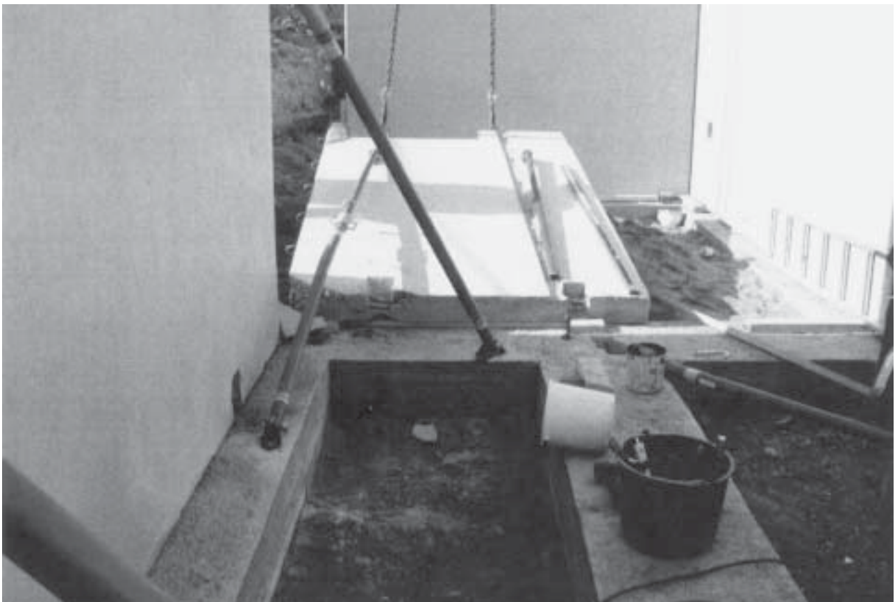
Kuva 2. Kaatunut elementti.
