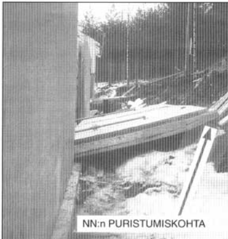
Kuva 3. Kaatunut maavallielementti.
