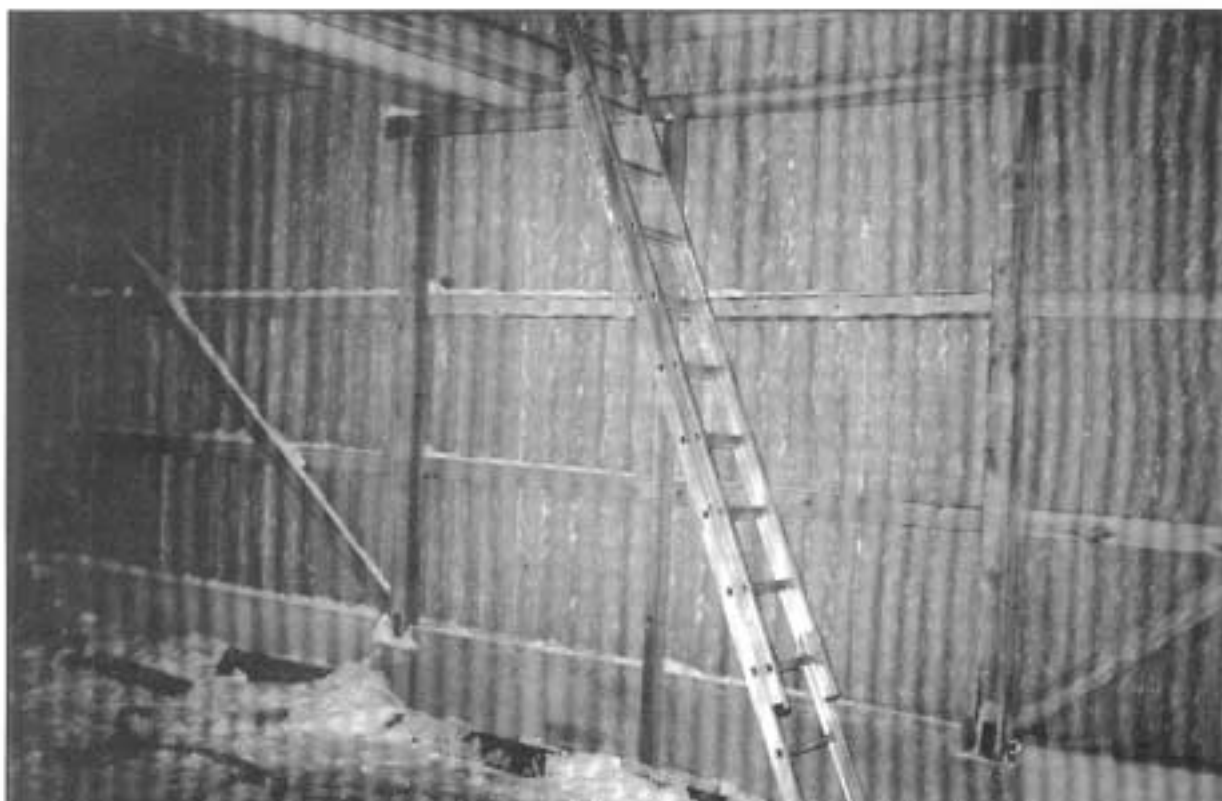
Kuva 1. Kuva onnettomuuskohtadista. Kuvan vasemmassa yläreunassa näkyy työtaso, jolle NW:n oli tarkoitus nousta.
