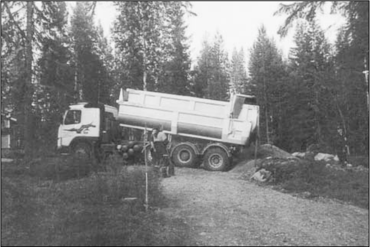
Kuva 1. Yleiskuva onnettomuuspaikasta ja ajoneuvon lavan asennosta tapaturmahetkellä.
