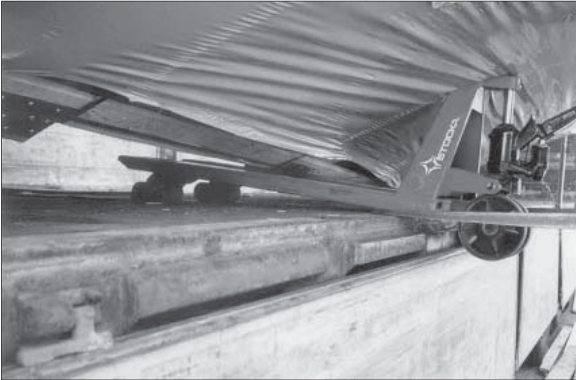
Kuva 3. Lavan reunalta alas pudonnut nostosiirtovaunu sekä kaatunut pakkauselementti.
