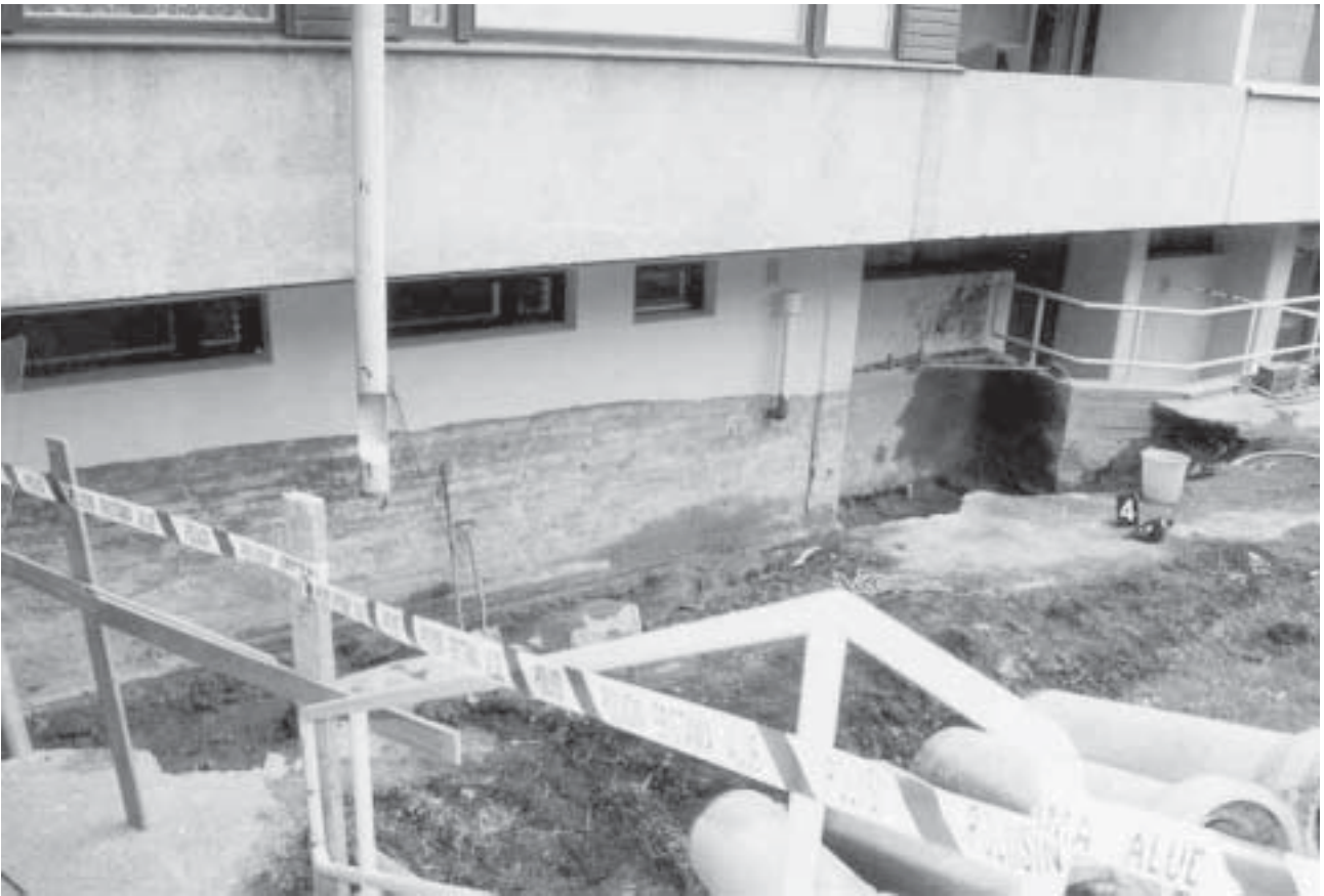
Kuva 1. Työmaa kerrostalon seinämän vieressä.
