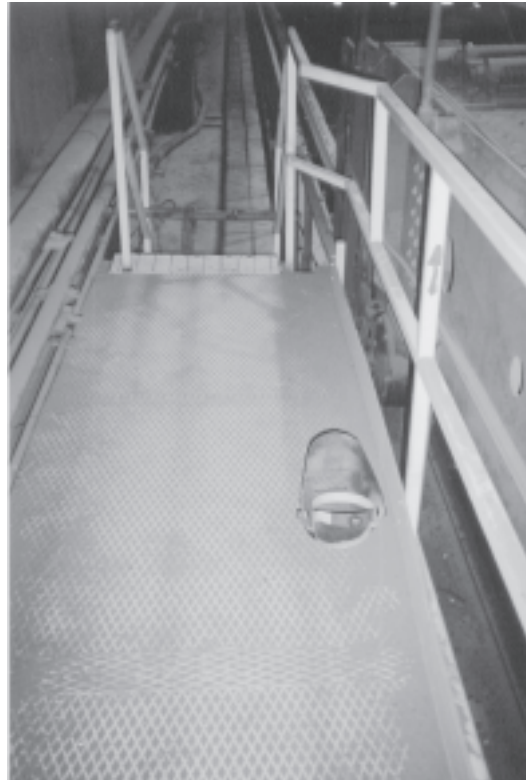
Kuva 2. NN:n nostama hitsausmas-ki ylemmällä kulktasolla. Siltanosturi on kohdassa, jossa tapaturma sattui.
