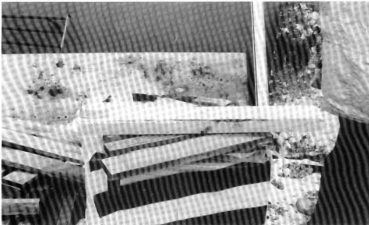
Kuva 3. Tiililetkan päällä soiro, joka oli irronnut toisen kerroksen ranskalaisen parvekkeen ovesta.
