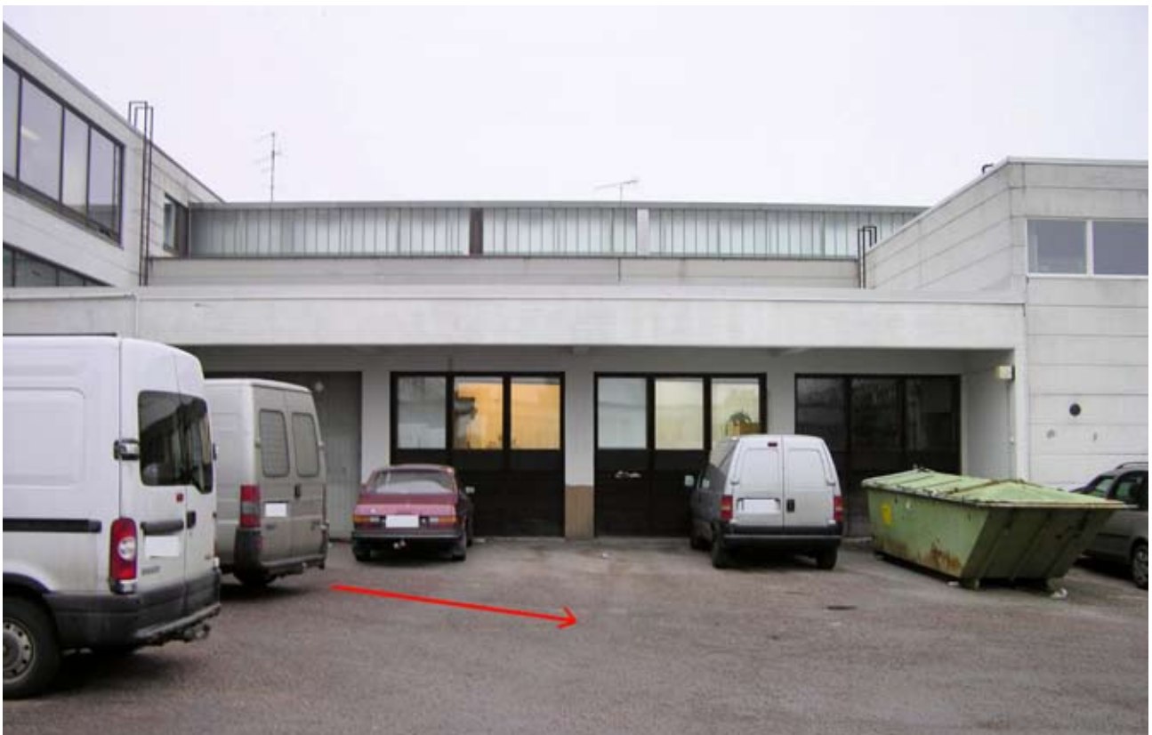
Kuva 1. Lastauspaikka, jossa jakeluauto oli kuvassa vasemmalla näkyvän taaemman pakettiauton paikalla. Jakeluauto oli laituriiin peruutettuna, nokka oli noin punaisen nuolen kärjen kohdalla. Kuvasta on peitetty tunnisteet.
