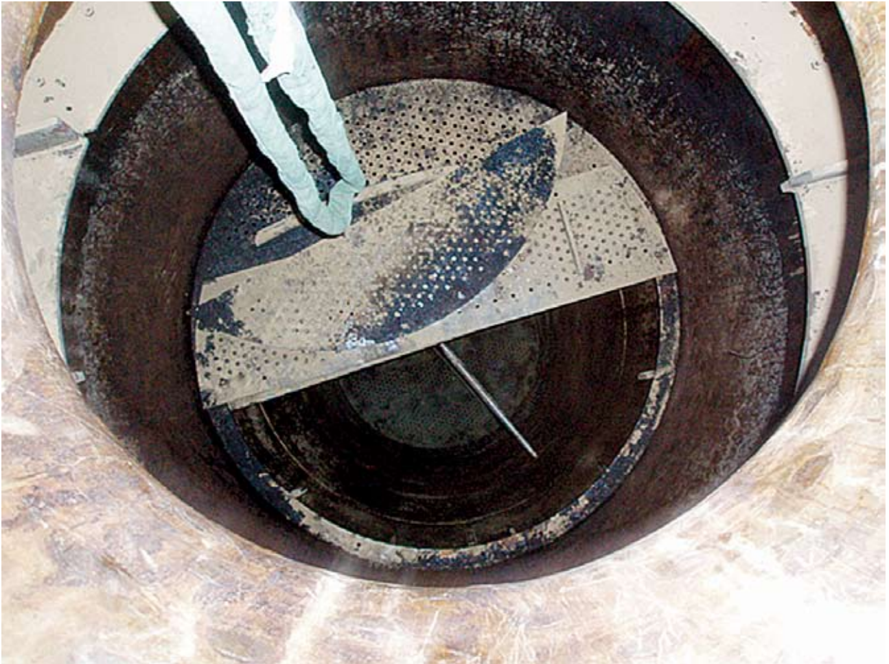
Kuva 4. NN putosi tikkaiden yläpäässä olleen solmun auettua puolittain puretulle välipohjalle yli 5 metriä.
