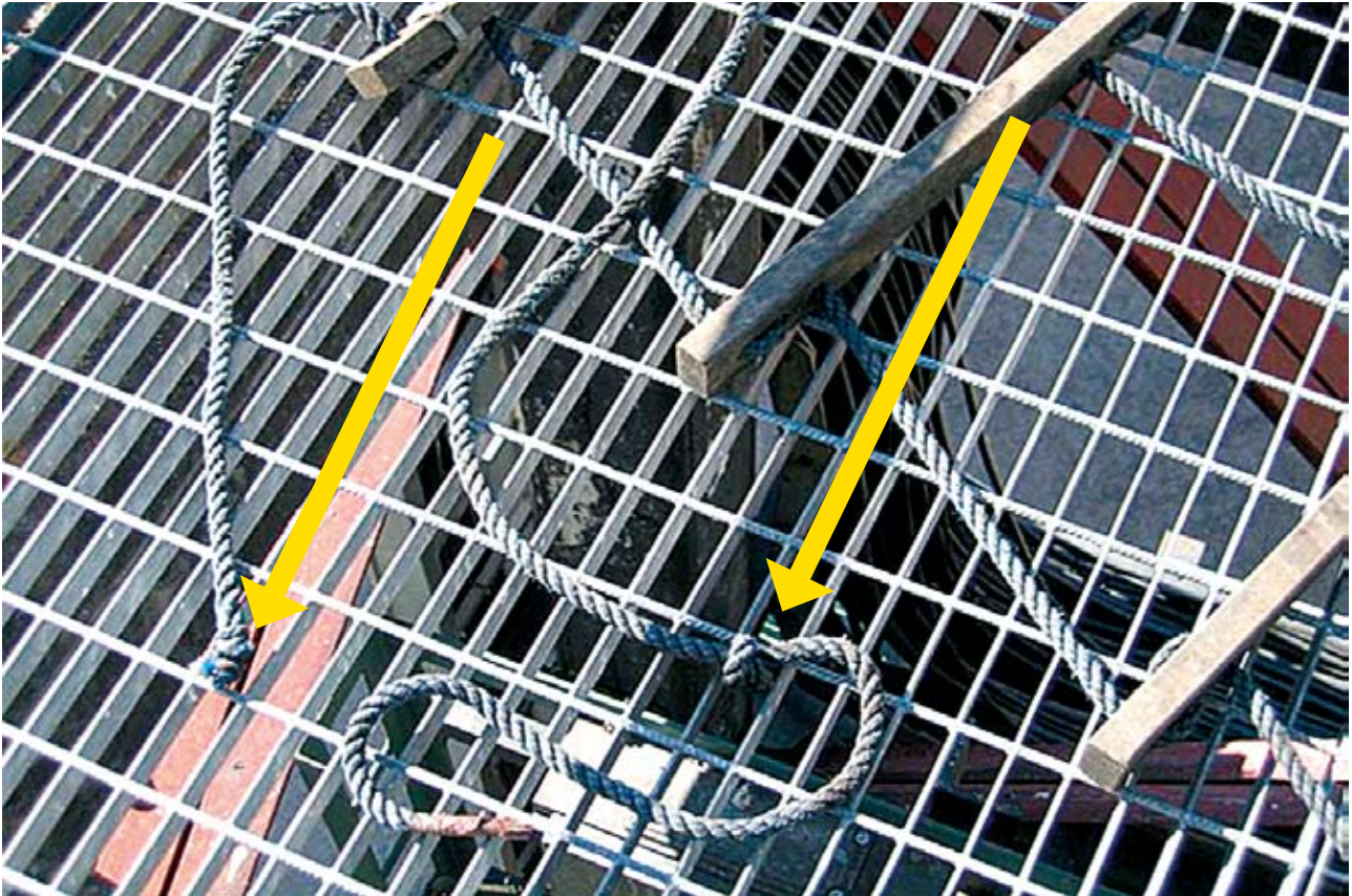
Kuva 2 Köysitikkaiden yläpää. Nuolet osoittavat köysiin tehtyjä solmuja.
