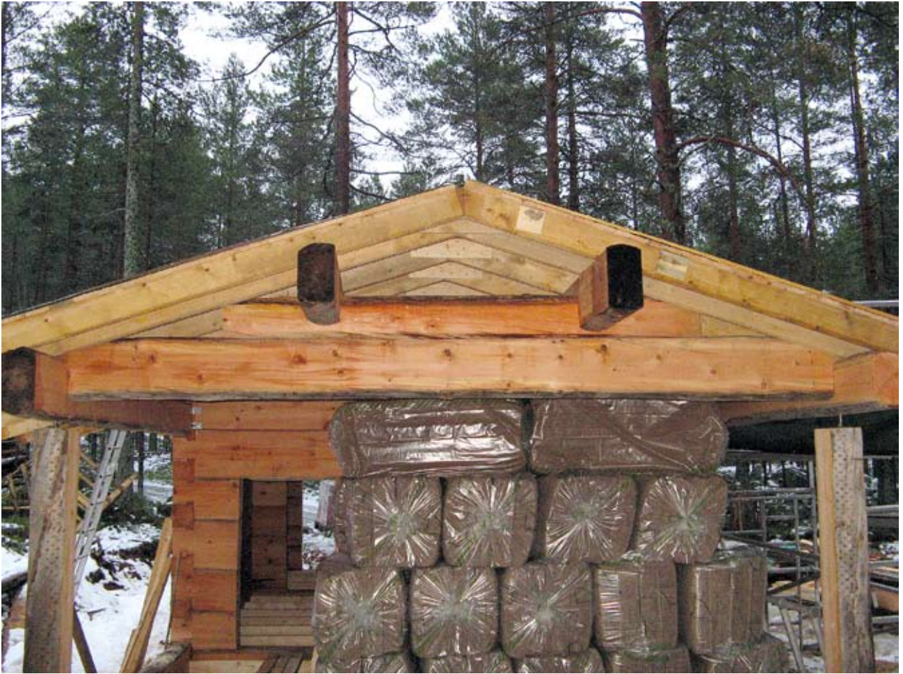
Kuva 2. Tapahtumapaikka myöhemmin kuvattuna. Tapaturman aiheuttanut päätykolmio on tässä vaiheessa jo asennettu paikoilleen.
