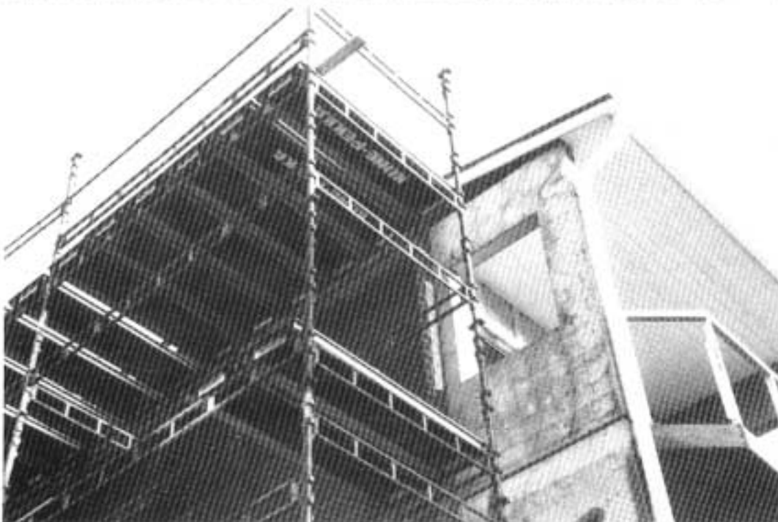
Kuva 1 ja 2. Telineet, työtasot (poistetut tasoelementit paikoillaan).
