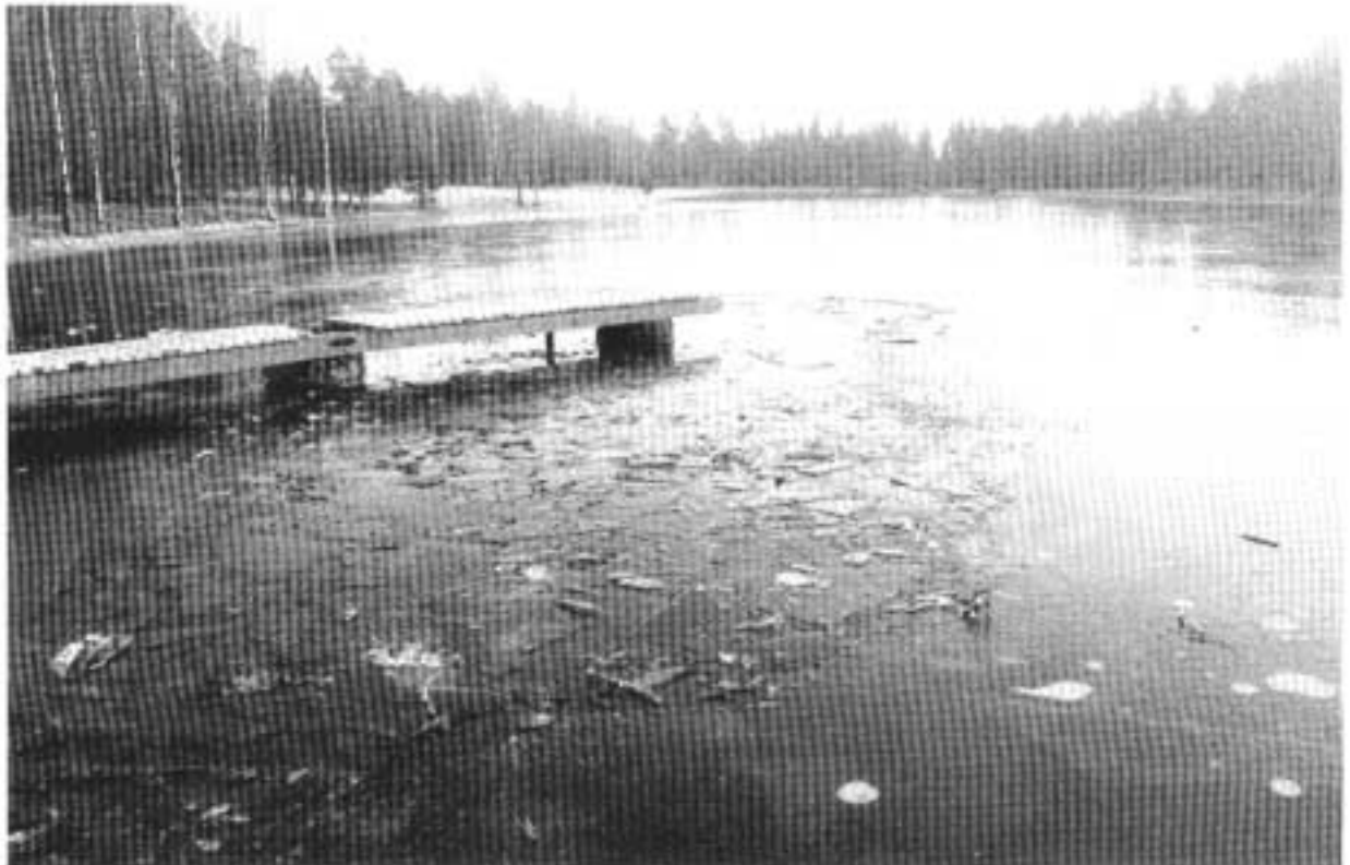
Kuva 2. Korjattavana ollut laituri.
