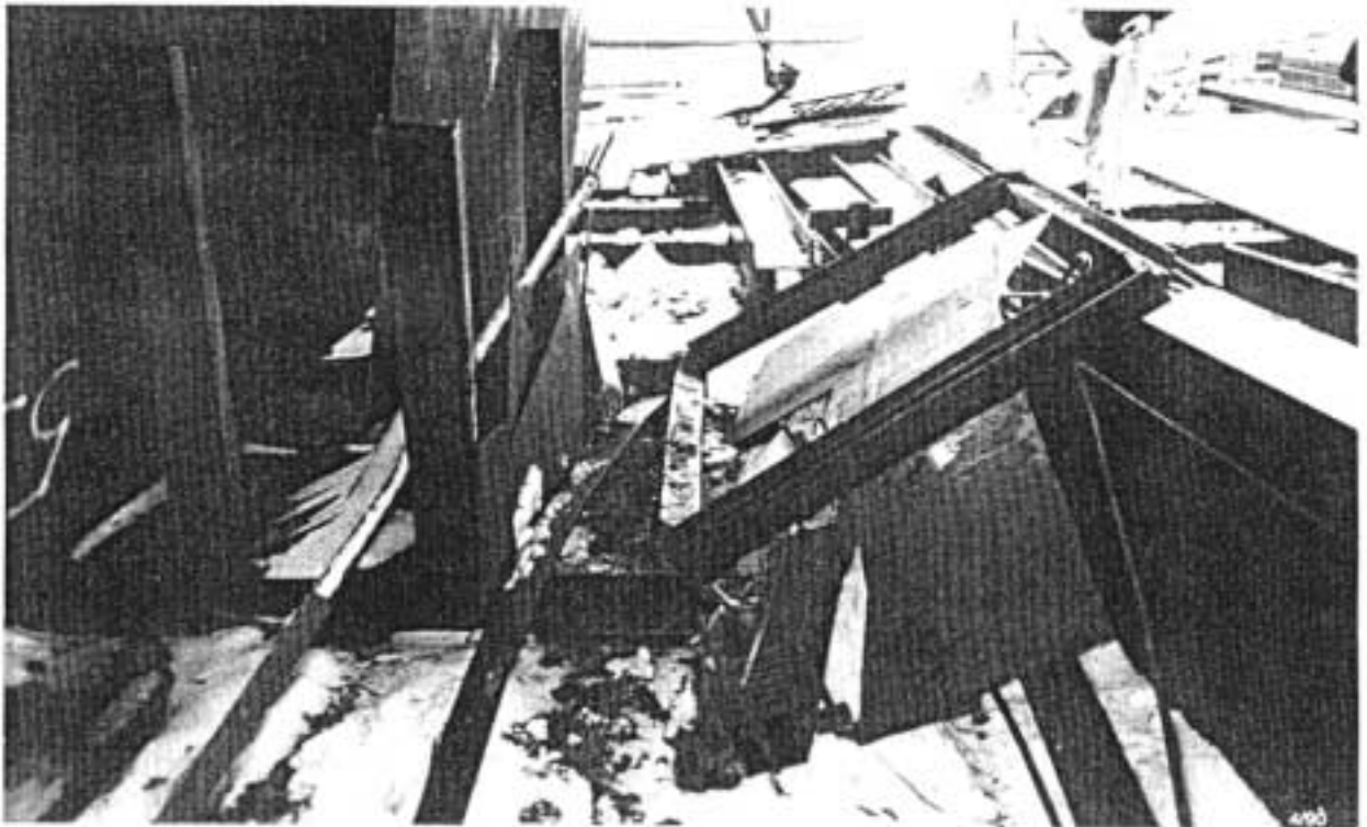
Kuva 2. Kuvassa levyvarasto ja etummaisheet, murtuneet levytuot nojallaan I-palkkia vasten.
