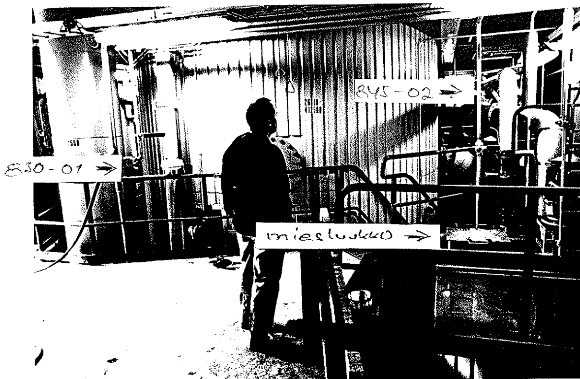
Kuva 1. Yleiskuva, venttiilit, miesluukku
