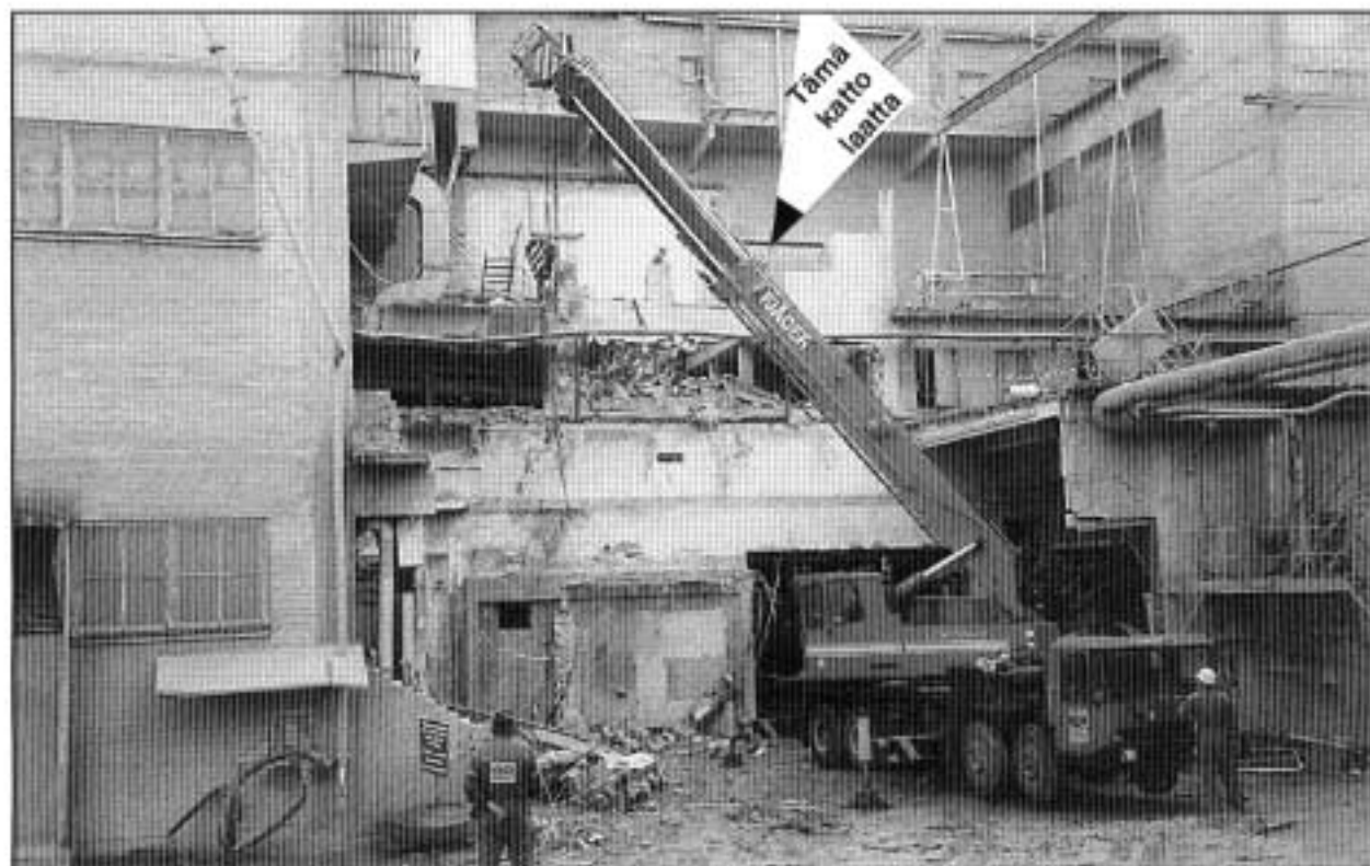
Kuva 1. Nosturi, jolla vajeria vedettiin. Yleisnäkömä.
