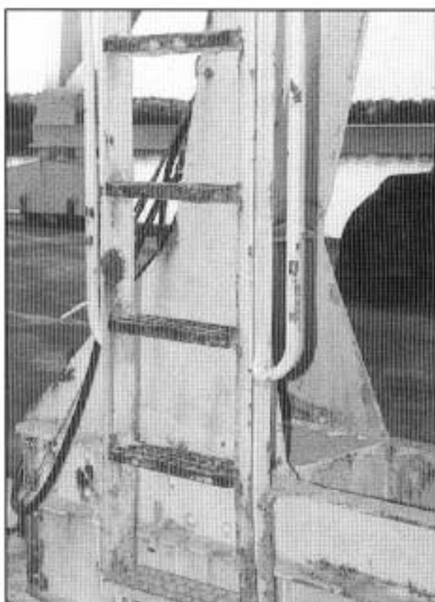
Kuva 3. Lähikuva porrasaskelmista ja kaiteesta.
