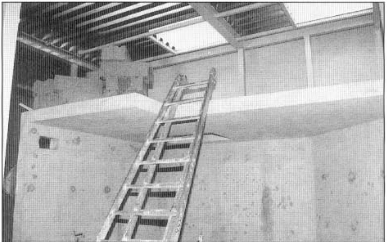
Kuva 2. Tikkaat, joita pitkin NN nousi IV-huoneen katolle. Tikkaiden takaa näkyy aukko, johon NN putosi. Ylhäällä kaksi avointa nostoaukkoa ja vasemmalla ylhäällä lekaharkkoja.
