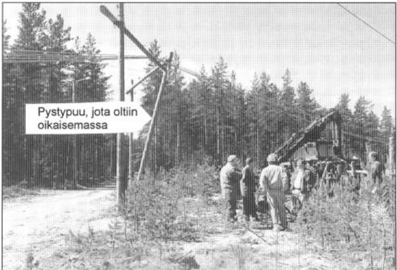
Kuva 2. Vinoon mennyt asennuspukki.
