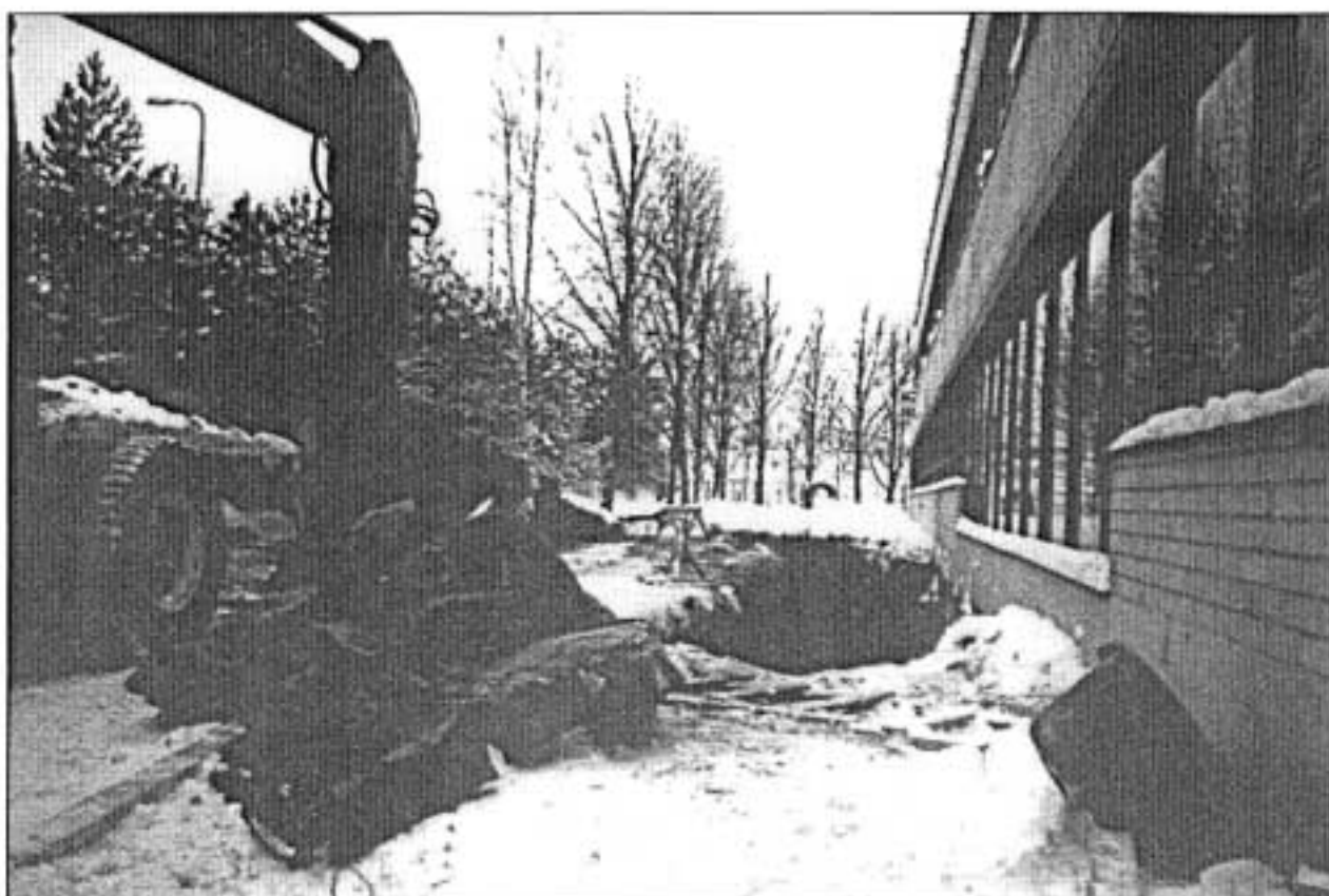
Kuva 2. Seinän viereen kaivettu kaivanto.
