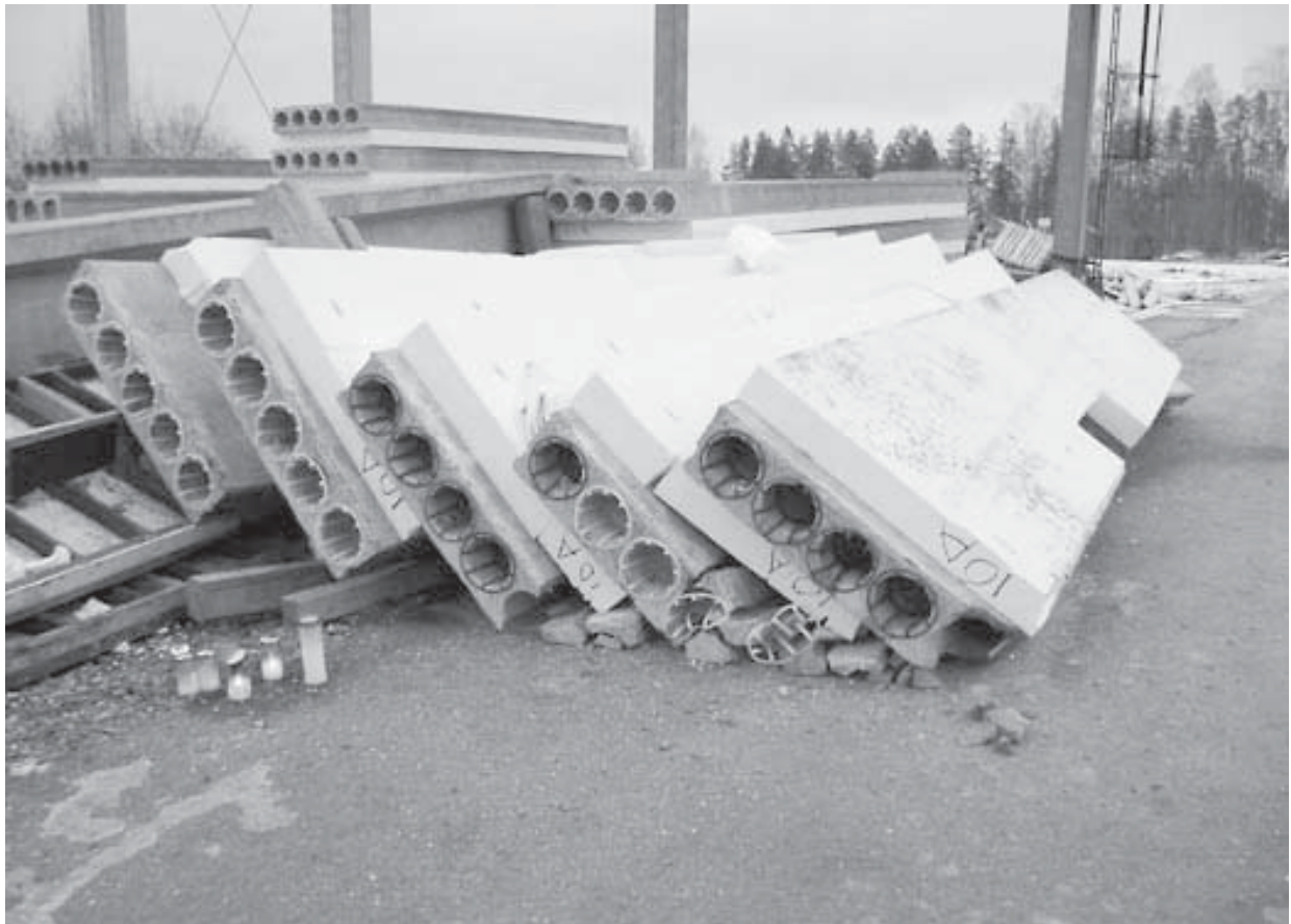
Kuva 1. Maahan pudonneet ontelolaatat. NN jäi kynttilöiden kohdalla laattojen alle.
