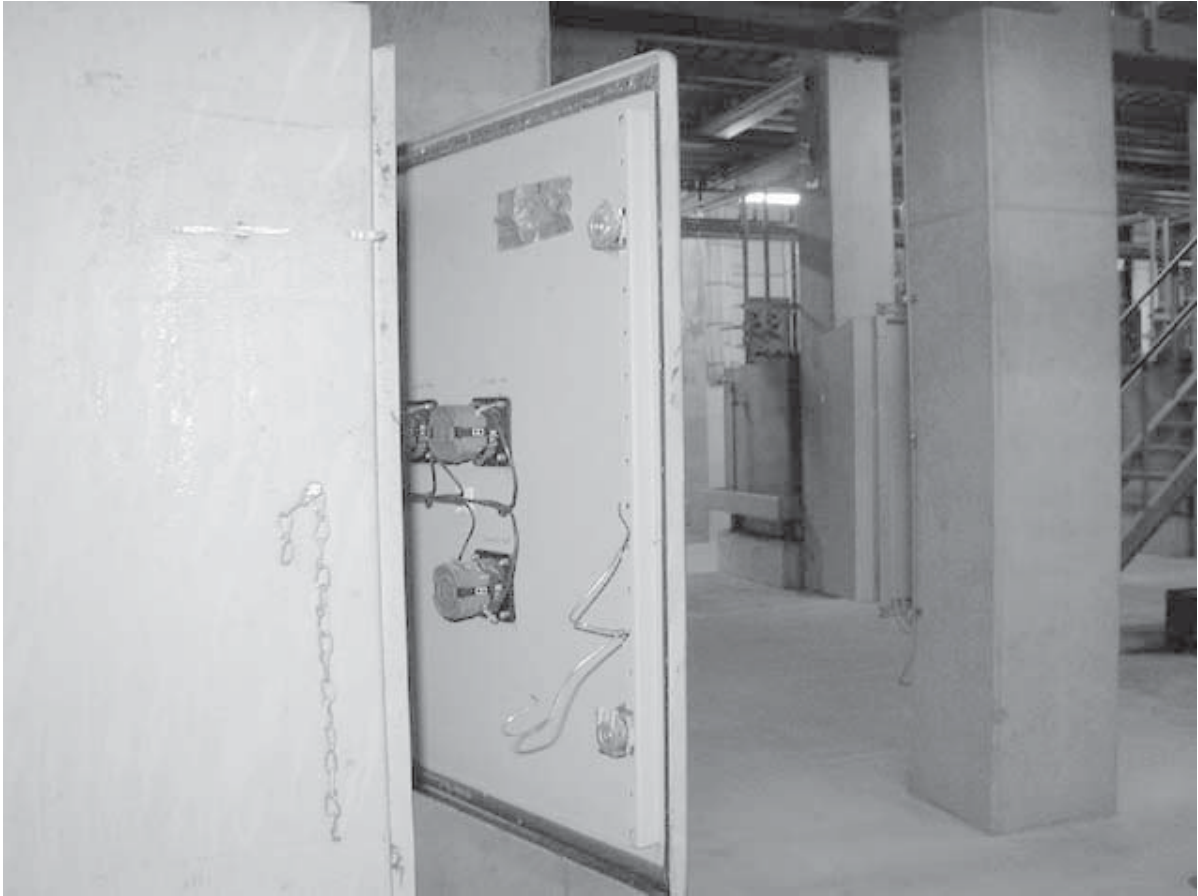
Kuva 2. Paikallishjauskotelo, jossa tapahtunut oikosulku avasi romuloukut.
