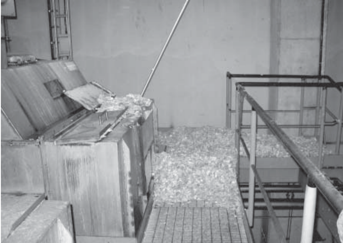
Kuva 3. Hakepesuri ja sen hoitotaso tapaturman jälkeen. NN survoi poistoputkea kuvan keskellä hakepesurissa pystyssä olevalla rautaputkella.
