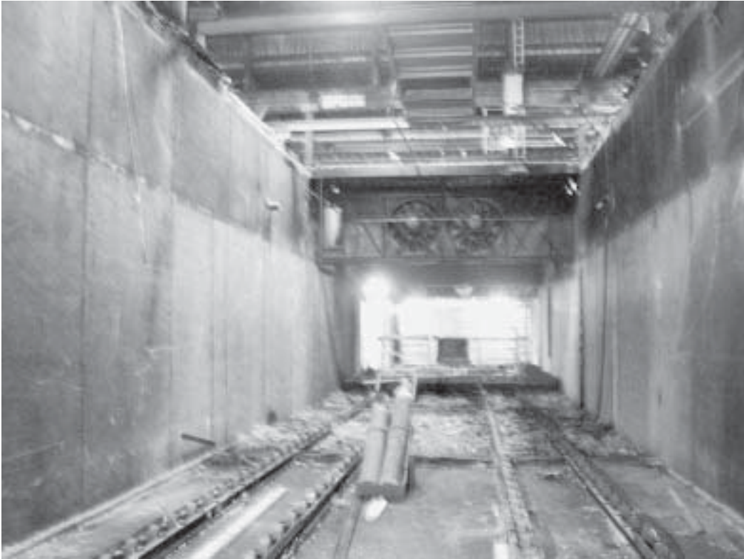
Kuva 1. Yleiskuva kanavakuivaamon alakerrasta. Kuvassa ylhäällä näkyy lämminpuhaltimet, jonka päällä olevalta “purkamattoman välikaton osalta” NN putosi lattialle. NN kulki vasemmalta oikealle. Lattialla on kaasupullokärryt ja niistä lähtevät letkut näkyvät “purkamattoman välikaton osan” oikeassa reunassa.
