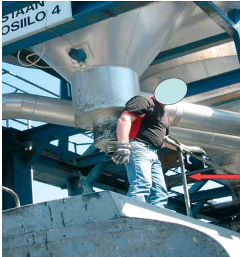
Kuva 3. NN ei nostanut kuljettamansa yhdistelmäajoneuvon perävaunun vasemmalla puolella olevaa suojakaidetta (nuoli) rehun lastauksen ajaksi. Todennäköisesti suojakaide olisi estänyt putoamisen.
