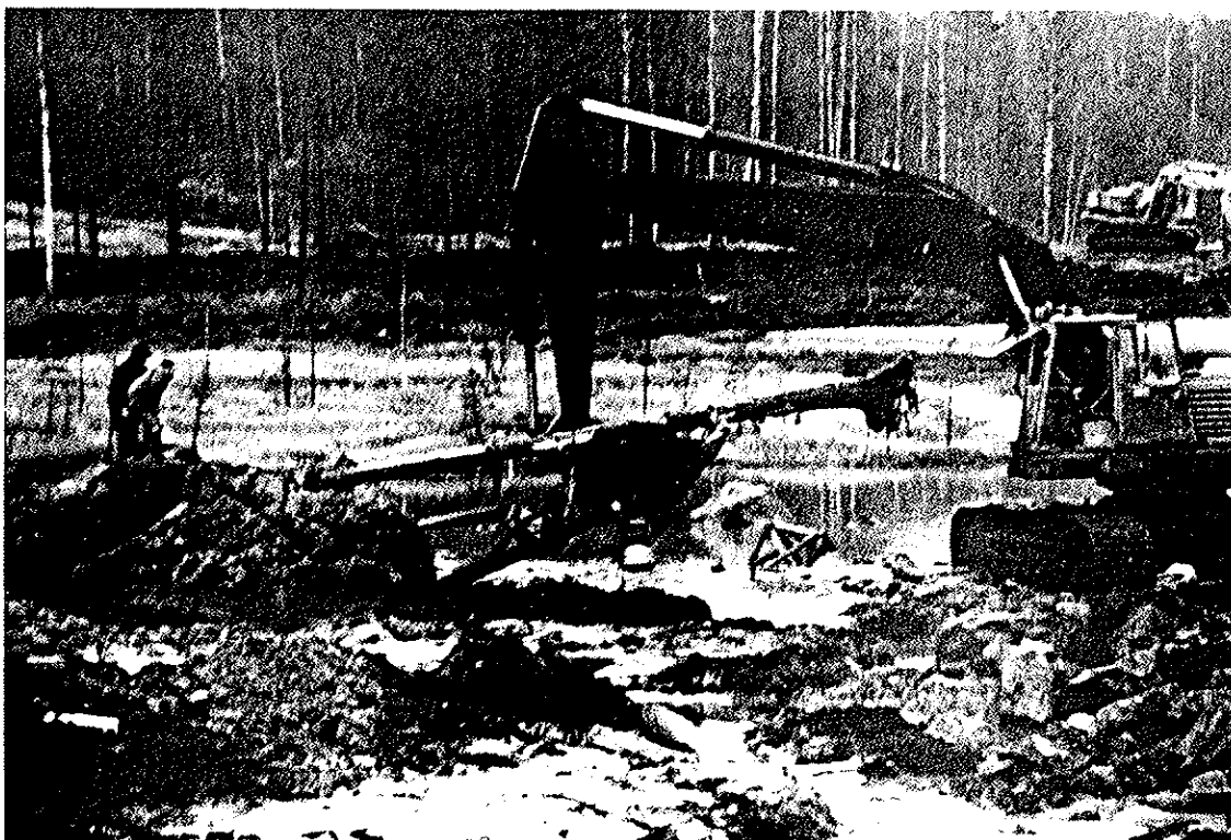
Kuva 3. Tukki ja pumput kaivinkoneen kauhassa
